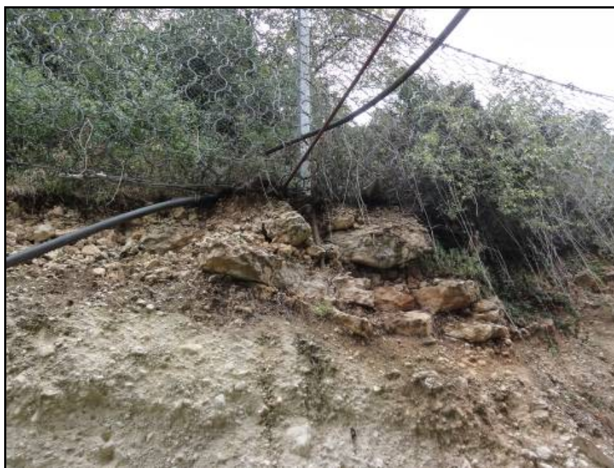
Fig. 17 – Particolare della fondazione della barriera paramassi.
