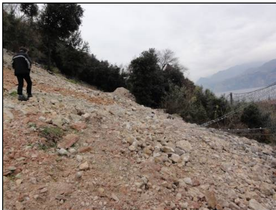
Fig. 16 – Particolare dell’eliminazione del gradino morfologico con riprofilatura del versante.
