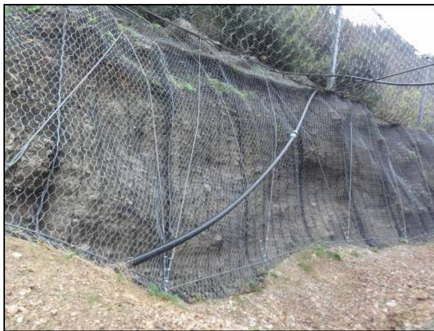
Fig. 19 – Particolare della parte basale delle barriere per il contenimento del materiale detritico.
