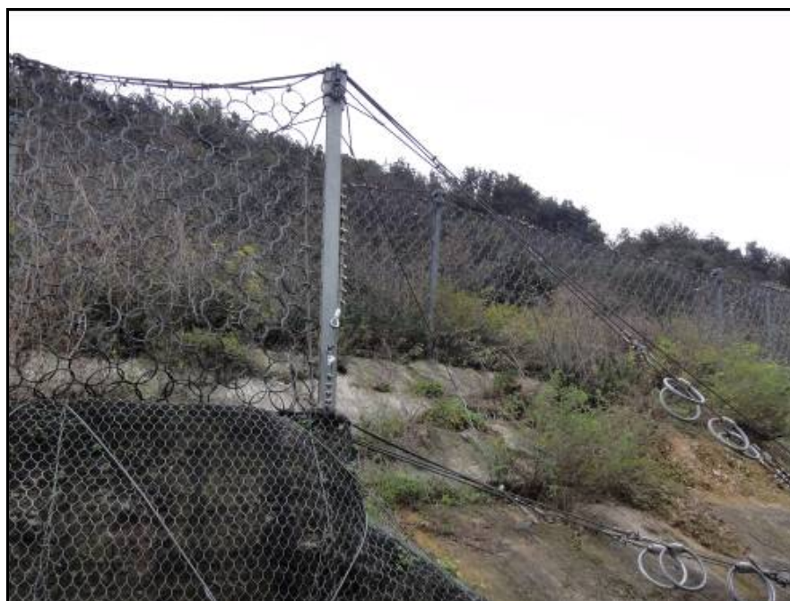
Fig. 20 – Particolare del pilone della barriera paramassi che a seguito del ripristino è stato tirantato.
